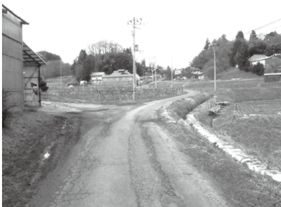
改良予定の町道岩田馬千内線
