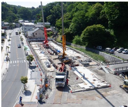
全景（令和 2 年 6 月 2 日撮影）
