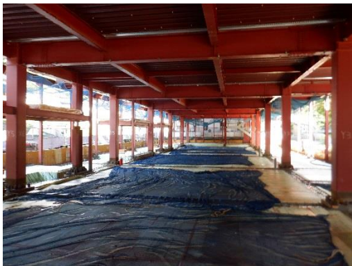
1 階の様子（令和 2 年 7 月 8 日撮影）
