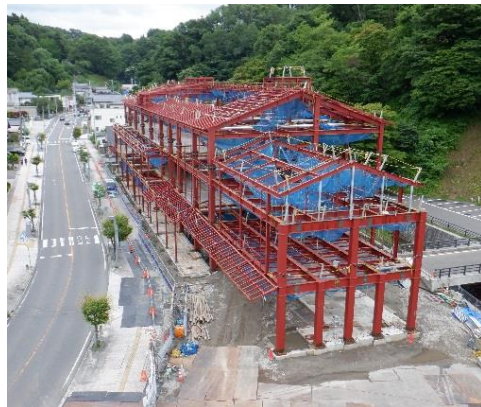
全景（令和 2 年 7 月 1 日撮影）
