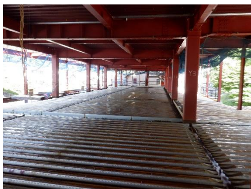
2 階の様子（令和 2 年 7 月 8 日撮影）
