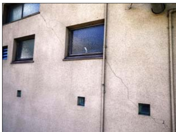
（役場庁舎外壁面）
