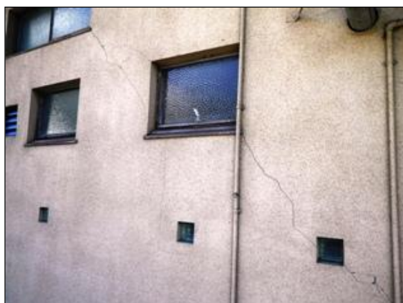
（役場庁舎外壁面）
