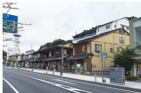
【修景された「大町おまつり道路」】
