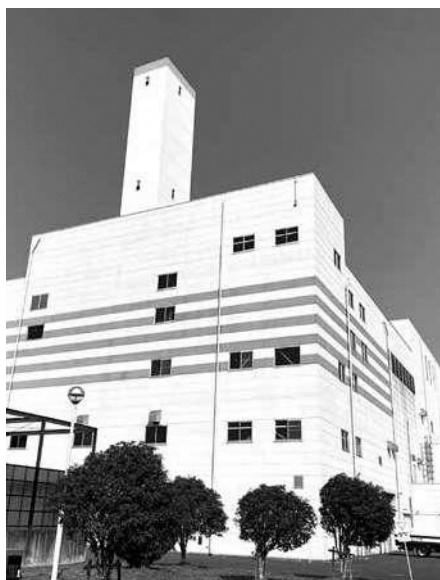
田村西部環境センター
