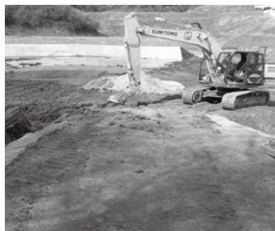
大根房ため池工事
