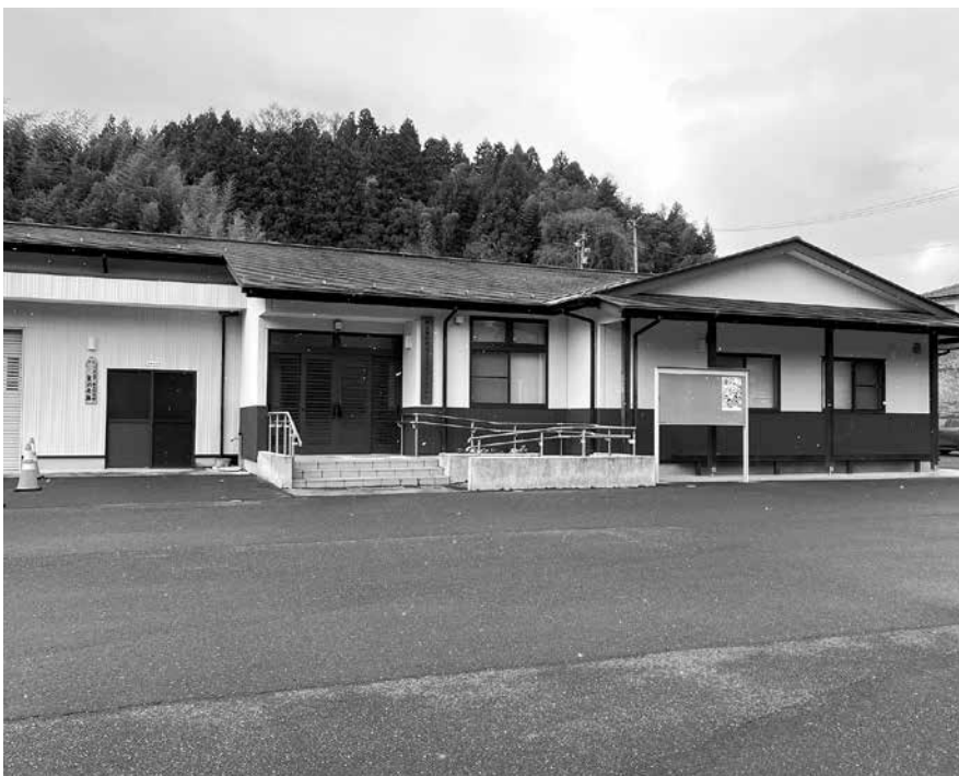
地区避難所岩江防災コミュニティセンター
