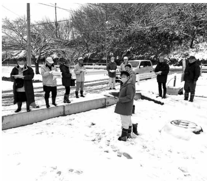
宅地造成現場
