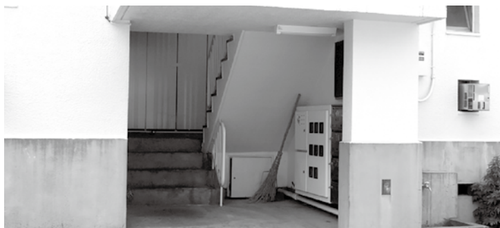
一般町営住宅（段差ある玄関）
