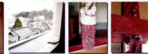
建築当初はベランダで手摺付 朱塗の彫刻は改造 木部は全て漆塗り
