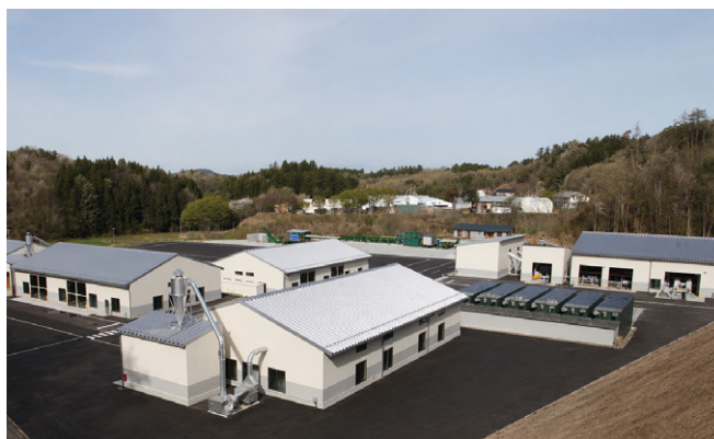
完成した第2工場
