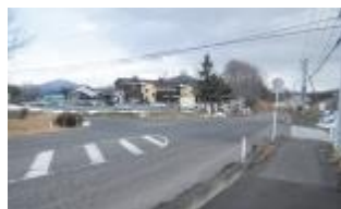
町道整備（西方）
