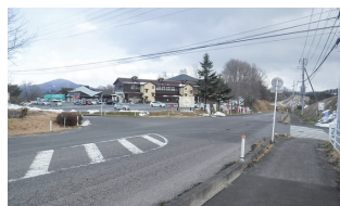
町道整備（西方）
