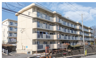
駅南ヶ丘団地 57 号棟
