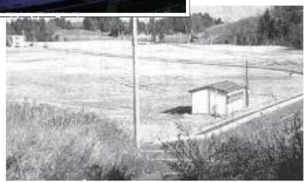
▼造成中の 平沢工業団地
