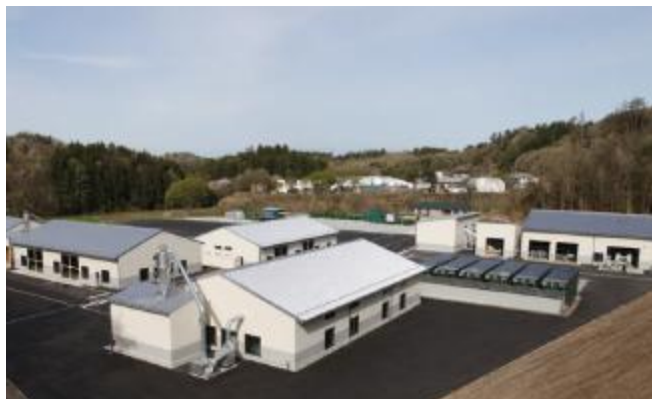
完成した第2工場
