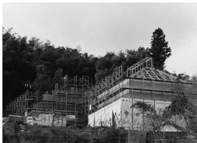
建設中の歴史民俗資料館（昭和56年）
