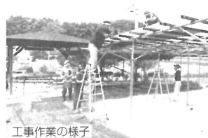
工事作業の様子
