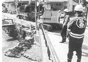
▲平成6年4月27日午前8時30分から午後7時まで、地元消防団及び建設業社の協力により町が実施した桜川土砂上げの様子
