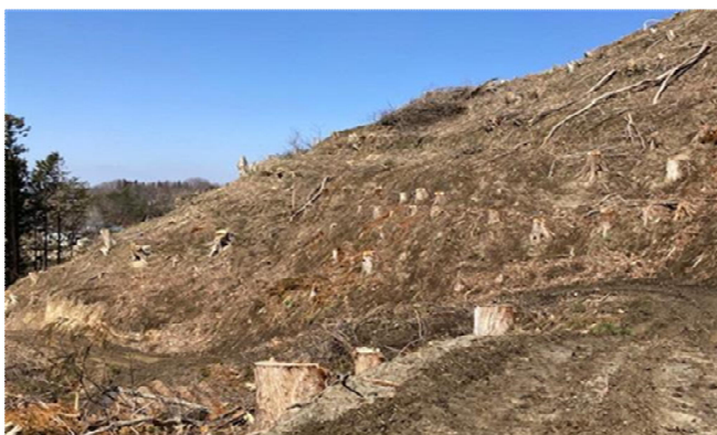
（広葉樹林整備）
