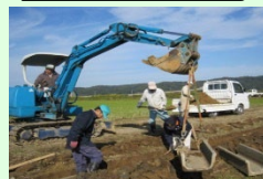
コンクリート水路の更新
