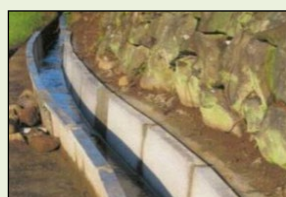
素堀り水路からの更新
