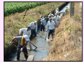
水路の泥上げ
