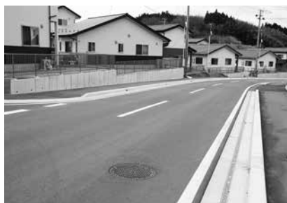
住宅団地内に整備された町道
