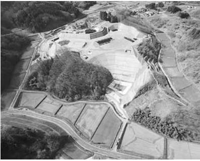
北部三地区仮置場
