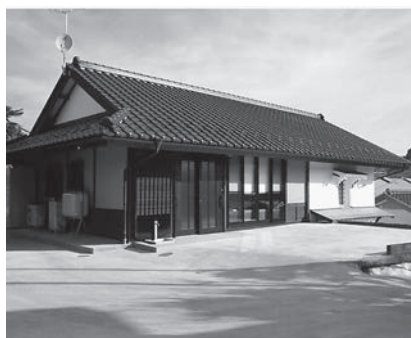
第20回建築賞受賞建物
