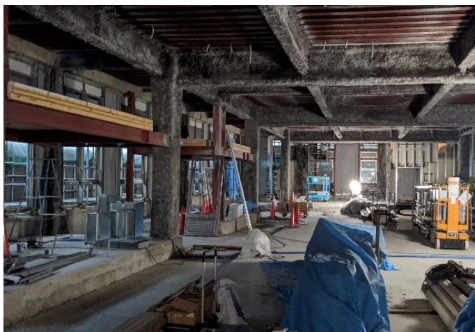
1階「執務室」(R2.10.14 撮影) 鉄骨の耐火被覆を施工しました
