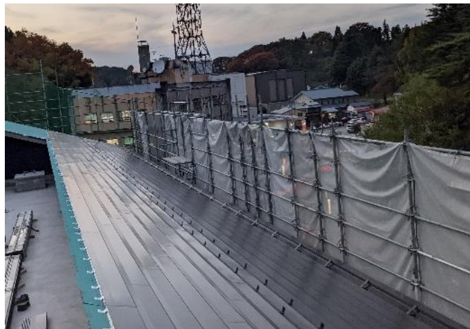
屋上 (R2.10.28 撮影) 屋根材を設置しています
