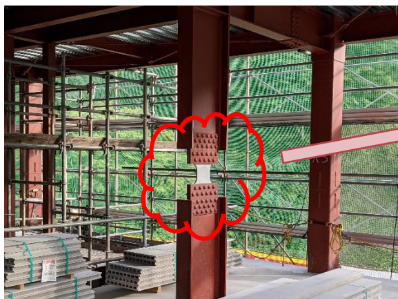
↑ 柱への取り付け状況 グレーのものがレンズダンパー
