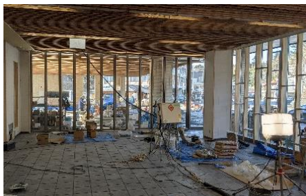
1階【多目的ホール】
