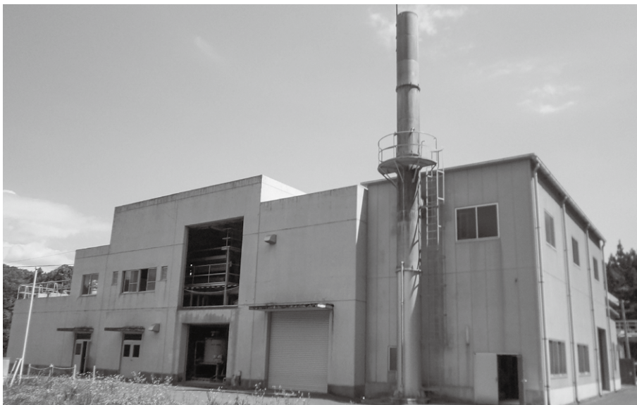
し尿処理を行う三春水環境センター
