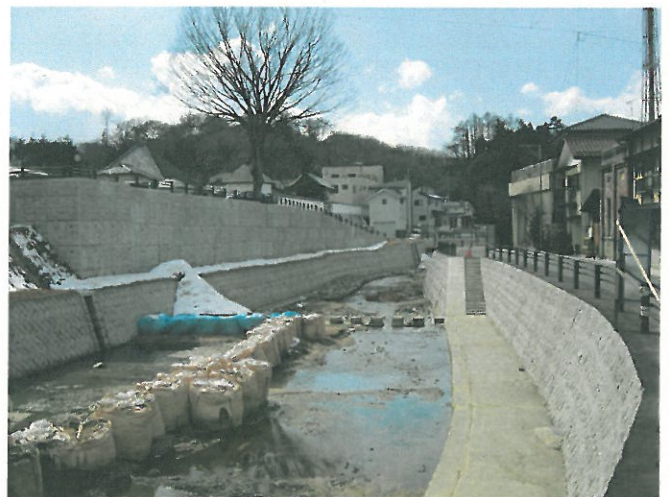
桜川河川改修工事(福島県発注工事)
