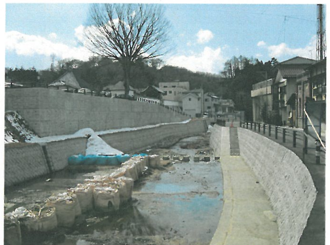
桜川河川改修工事(福島県発注工事)
