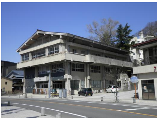
解体予定の旧公民館
