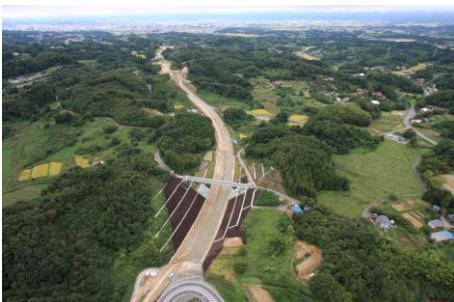
完成間近の 国道288号BP
