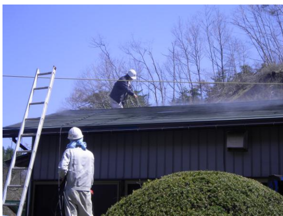
富沢7組集会所（モデル地区）除染の様子
