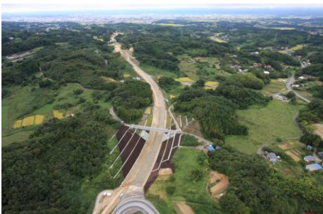
完成間近の 国道288号BP
