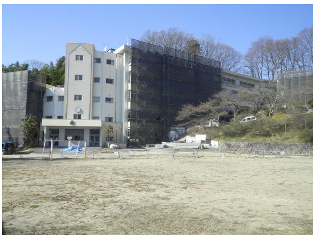
【耐震化工事が進む三春小学校】
